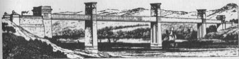
Puente tubular, Inglaterra
